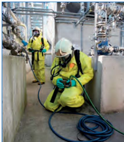
Abdichten der Leckage
